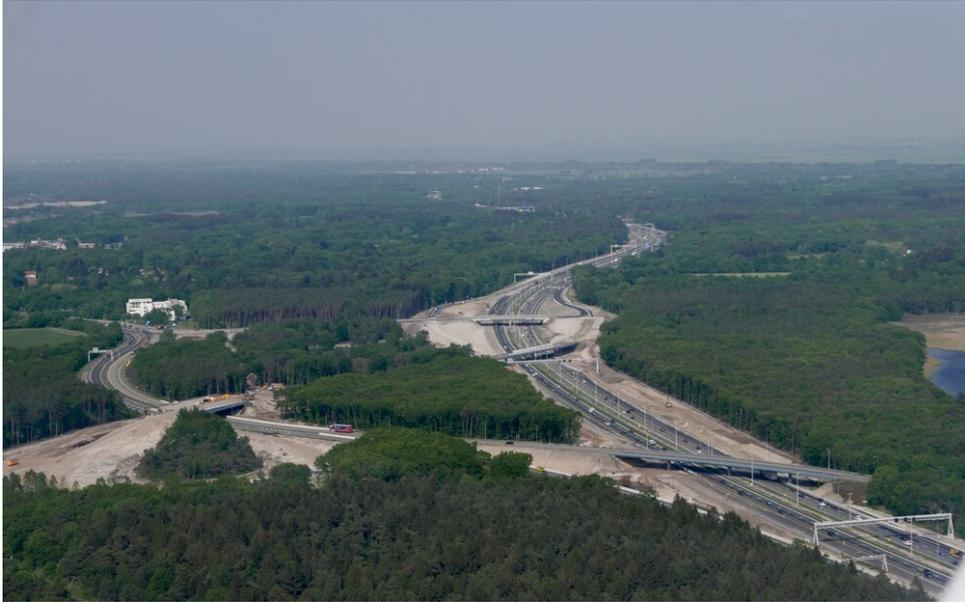
*Bauarbeiten an der A27 bei Hilversum, wo die ungenutzte Verbindung zur nie fertiggestellten A80 entfernt wird*
