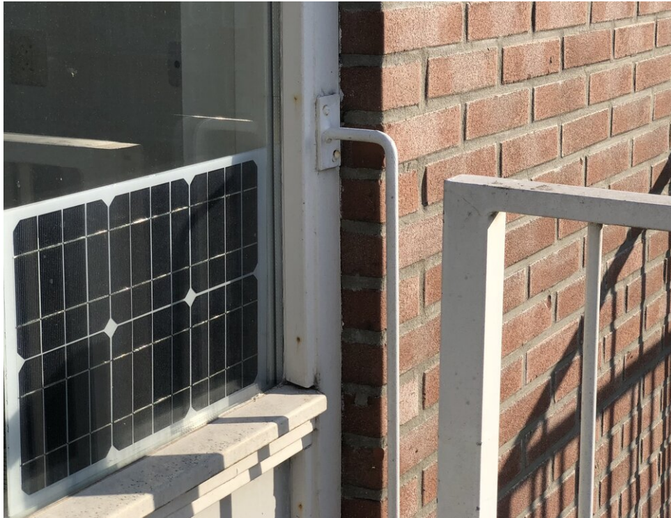
Het zonnepaneel direct achter het glas geplaatst
